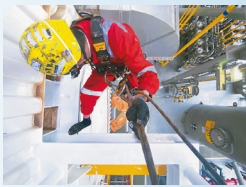
“蜘蛛人”凭借悬挂的吊绳进行油漆作业。
